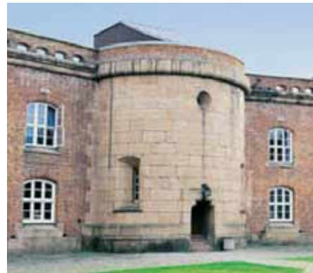
Oscarsborg festning, Drøbak: Rehabilitering av mur
