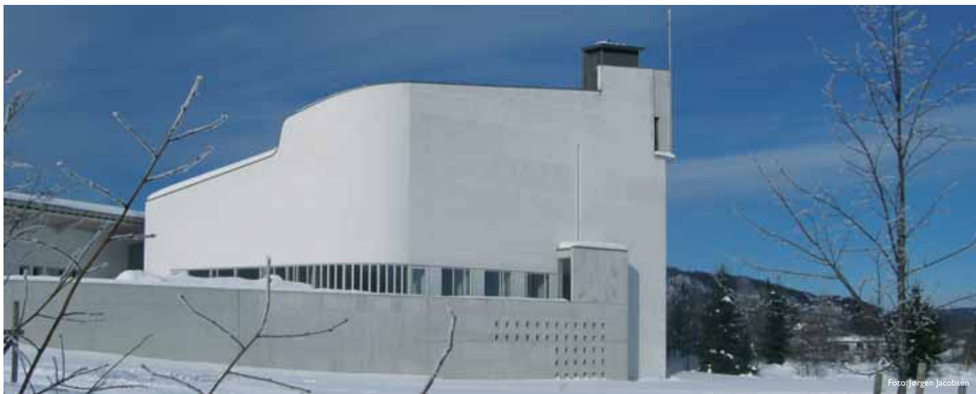
Vardåsen kirke, Asker: Mur og puss
