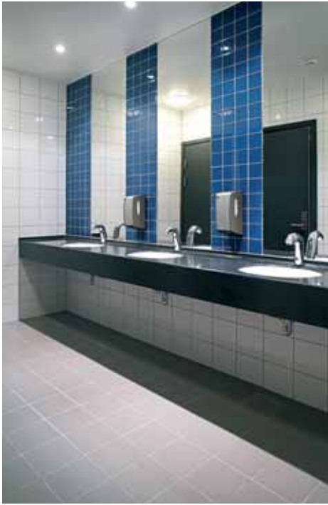
Moss Lufthavn, Rygge: Flisarbeider
